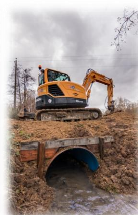
Remplacement d'une buse par une demie arche en PEHD sur le ruisseau du Crochet
