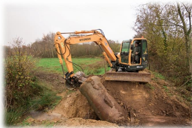
Remplacement d'une buse par une demie arche en PEHD sur le ruisseau du Crochet
