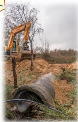
Remplacement d'une buse par une demie arche en PEHD sur le ruisseau du Crochet
